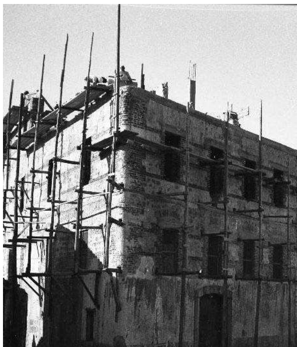
Costruzione della sopraelevazione del molino storico (fonte: EBAD)
