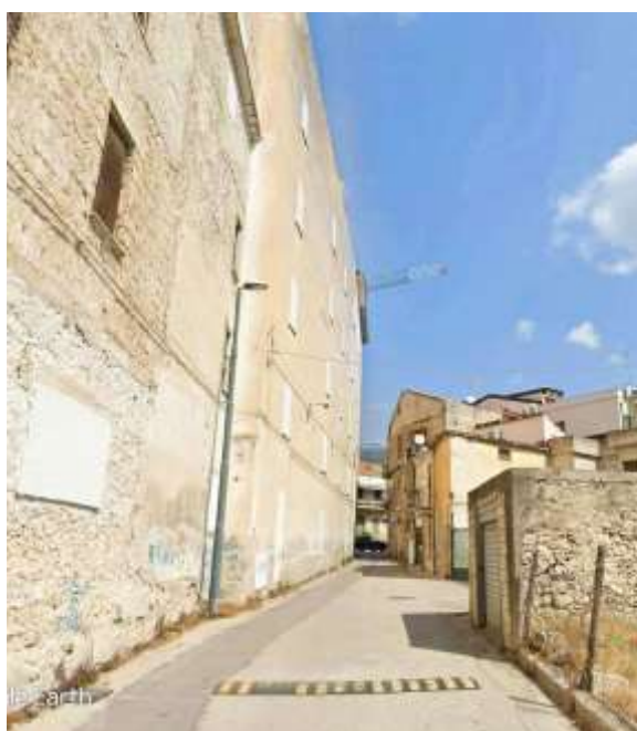
Prospetto edificio vincolato (da traversa Luigi Pezzullo)
