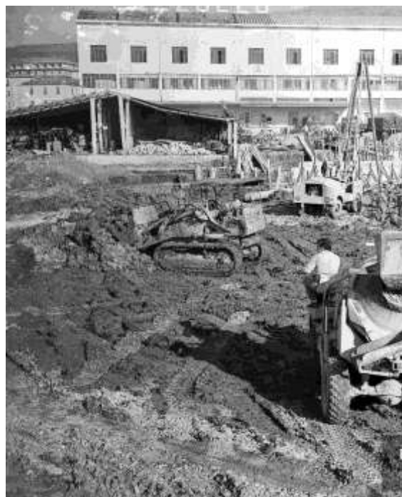
Lavori di ampliamento dello stabilimento pezzullo (fonte: EBAD)
