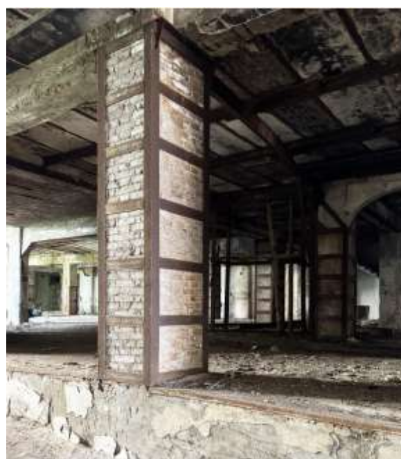
Interno Edificio Vincolato (struttura portante muratura)
