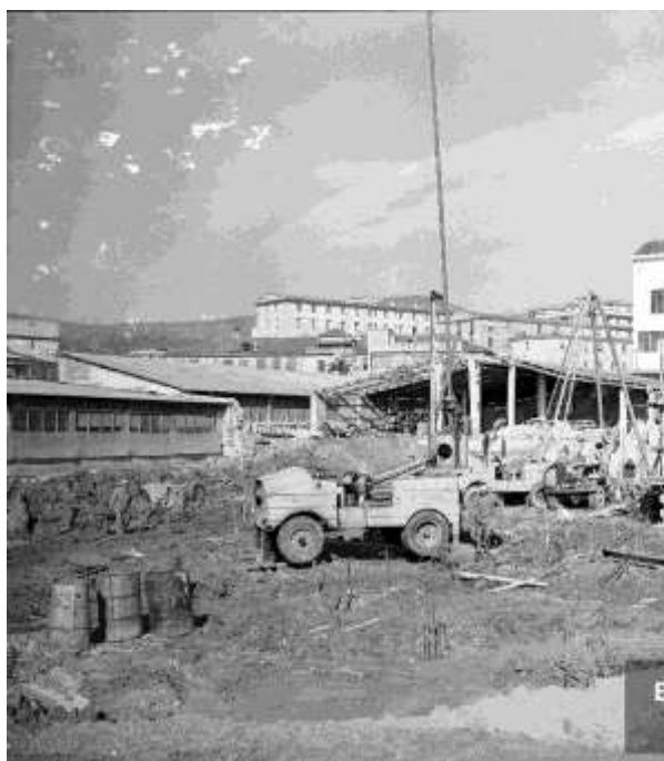
Lavori di ampliamento dello stabilimento pezzullo (fonte: EBAD)
