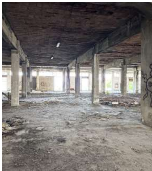
Interno Stabilimento (struttura C.A.)
