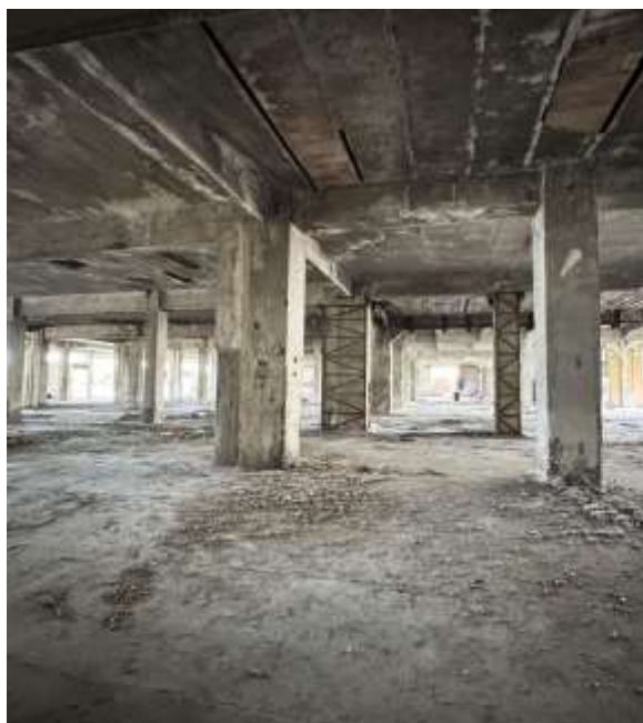
Interno Stabilimento (struttura portante mista)
