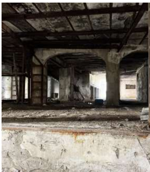
Interno Edificio Vincolato (struttura portante muratura)
